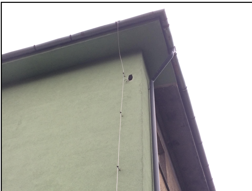
Obr. 2: Hnízdiště kavky obecné v díře zateplení na štítové straně č. p. 603
